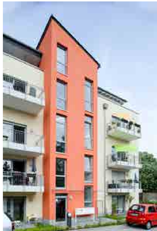
Separater Eingangsbereich für das „Wohnen mit Service“
